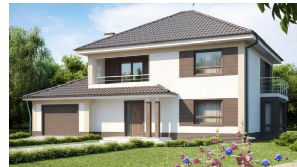
Усадебный жилой дом Вид №1
