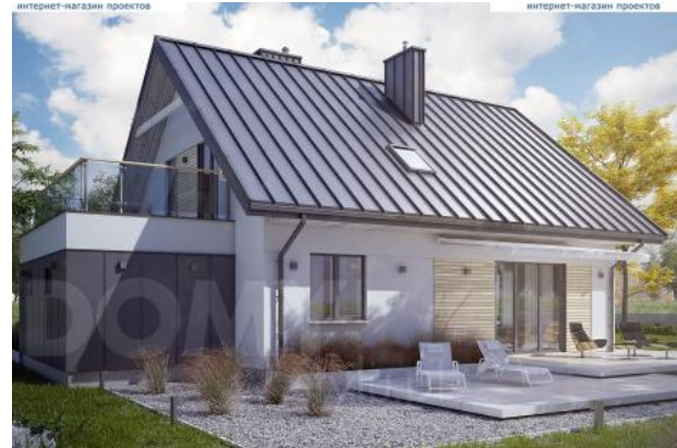
Усадебный жилой дом Вид №2
