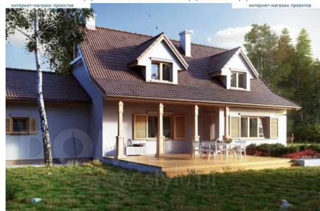
Усадебный жилой дом Вид №2
