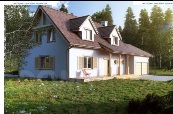
Усадебный жилой дом Вид №1
